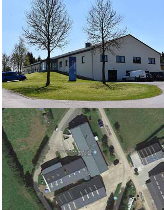
Die Beschützende Werkstätte „Die Zukunft“ Meyerode wird in 2018 mit einer 60 kW Photovoltaik-Anlage ausgestattet werden.
