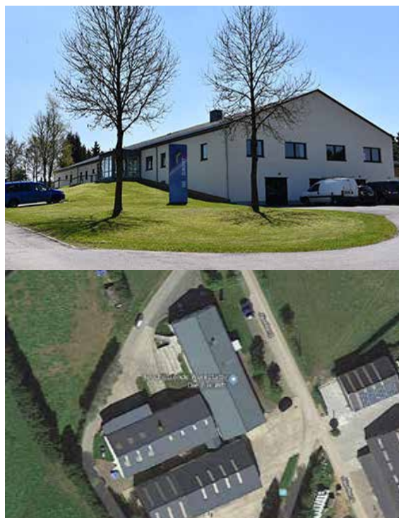
En 2018, les ateliers protégés de l'asbl « Die Zukunft » Meyerode verront leur toiture équipée de panneaux photovoltaïques d'une puissance nominale de 60 kW.
