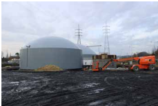
Die Biomethanisierungsanlage im Bau (© Pascal Verwoeren - CLEF)
