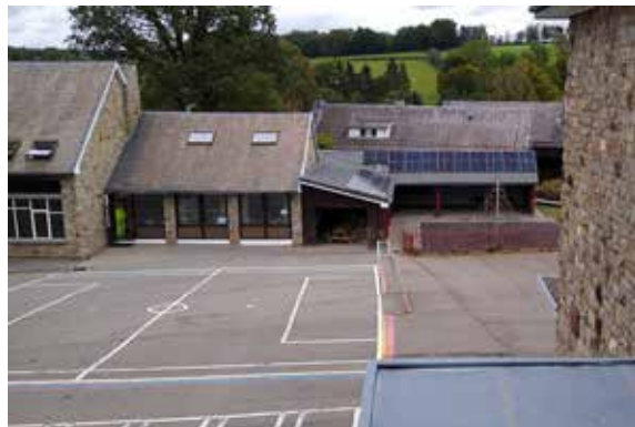
Schule Dorfmitte Weismes: Anlage 8 kWp
