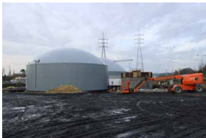
Le site de biométhanisation en construction (© Pascal Vermoeren - CLEF)
