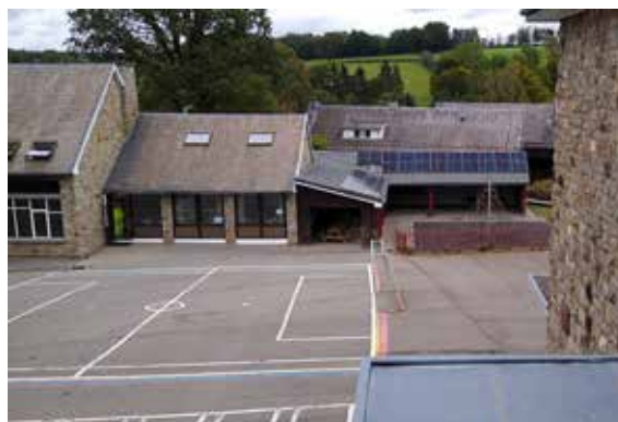
École du Centre à Waimes : installation de 8 kWc
