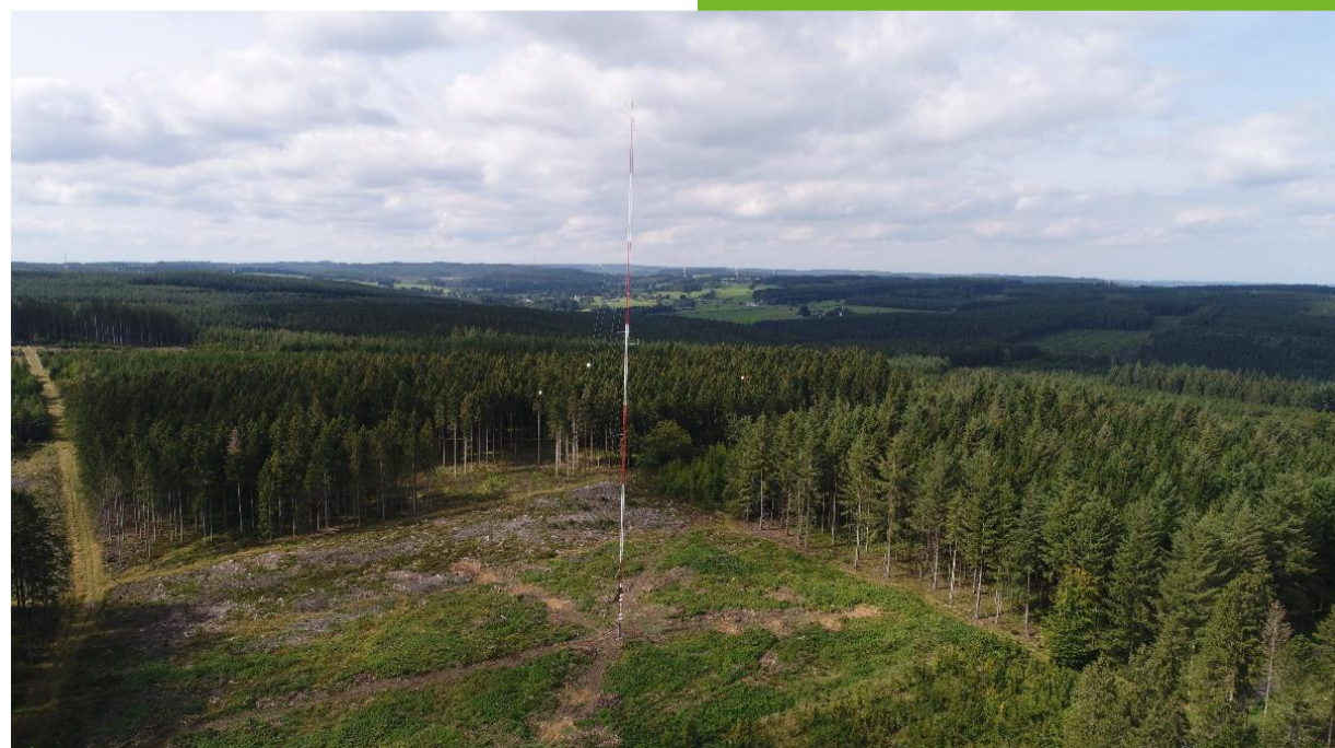
Les conditions de vent et l'activité des chauves-souris en hauteur ont été mesurés à l'aide d'un mât de 80 m de hauteur implanté entre les futures éoliennes 7 et 9, à un emplacement validé par le Département Nature et Forêts.
